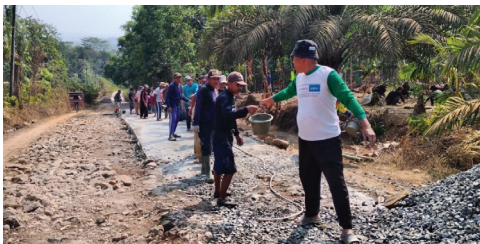
Puluhan warga bergotong royong memperbaiki jalan rusak ruas Lebak-Kadubadak, Desa Kadubadak, Kecamatan Angsana, Kabupaten Pandeglang.
