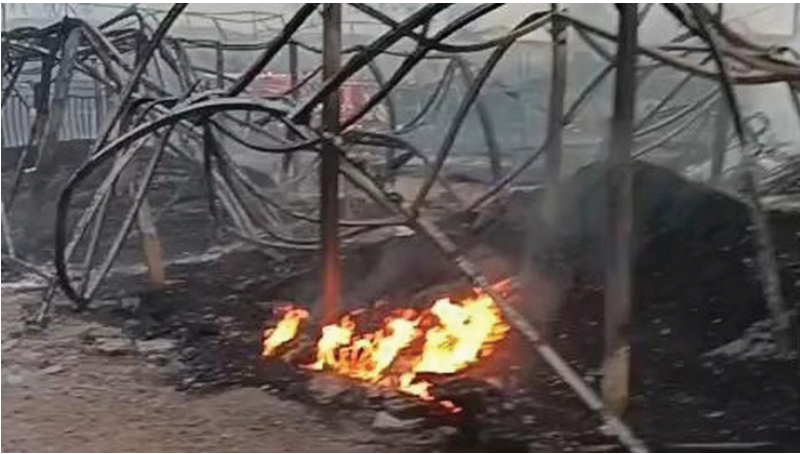
Tangkapan layar pabrik paralon yang terbakar.
